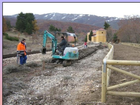
Ristrutturazione della stazione ferroviaria, realizzazione di canalizzazioni per acqua e gas e sistemazione delle aree esterne (vialetti in pietra; panchine, staccionate e pensiline in legno).
