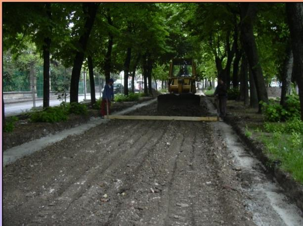
Fresatura della vecchia pavimentazione e particolare della preparazione del massetto e in cemento e dei cordoli in pietra.
