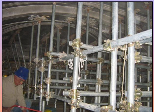
Puntellatura delle volte e consolidamento delle volte con rete in fibra di carbonio.
