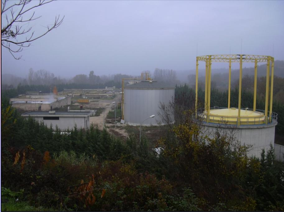
Veduta generale dell'impianto di depurazione, ed in primo piano il Gasometro, il Digestore e i locali tecnologici
