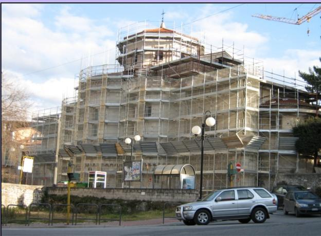
Rifacimento totale della copertura mediante l'utilizzo di coppi vecchi. Restauro e consolidamento delle absidi posteriori e dell'ingresso laterale della Cripta
